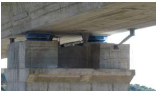
Γέφυρα ΣΓ12, κατασκευή με τη μέθοδο της σταδιακής προώθησης
