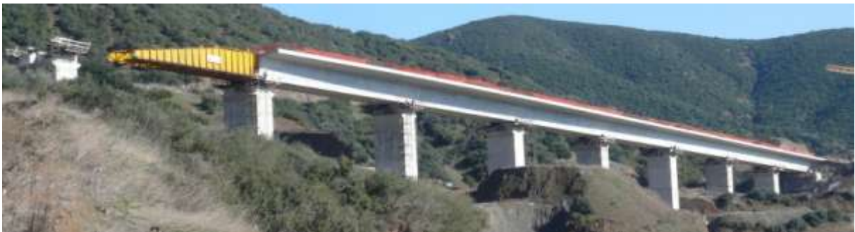
Γέφυρα ΣΓ14 πάνω και ΣΓ15 κάτω, κατασκευασμένες με τη μέθοδο της σταδιακής προώθησης
