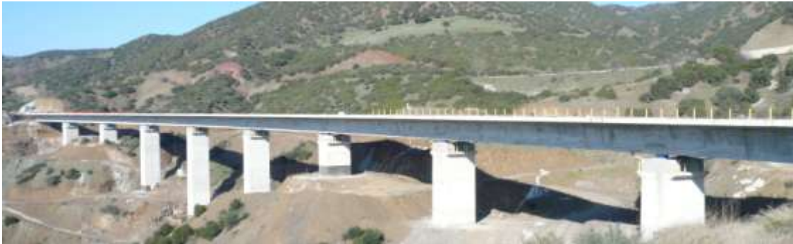
Γέφυρα ΣΓ14 πάνω και ΣΓ15 κάτω, κατασκευασμένες με τη μέθοδο της σταδιακής προώθησης
